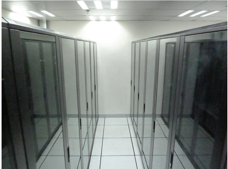
聯合網數據中心可容納14個600 x 960mm的機架。
